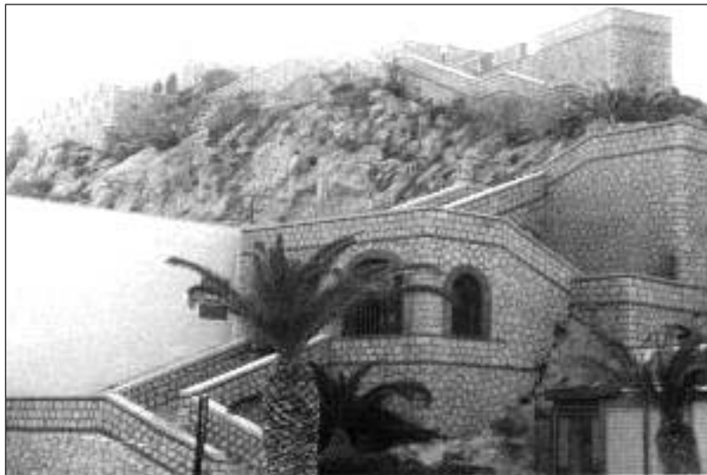
Veduta panoramica della Rocca e del castello
